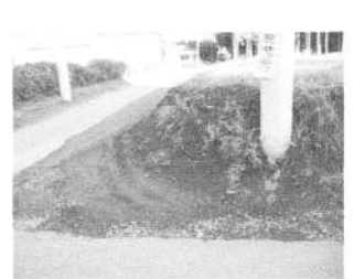
⑧新田団地北、西入口 電柱1本移設、道路拡幅 2005年
