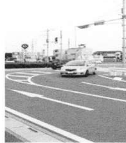
③国道299号バイパス 青木地区 側道相互通行 2005年
