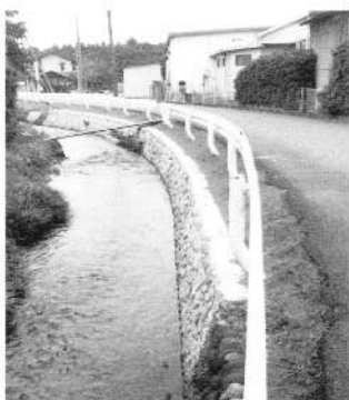
⑮芦荻場 南小畦川 路肩、護岸工事 2006
