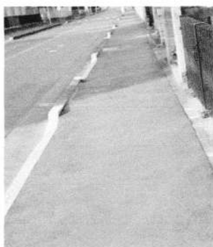
⑯富士見通り富士見団地東 歩道の段差解消 2007
