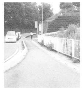
⑫防災センター入口 歩道整備 2002年
